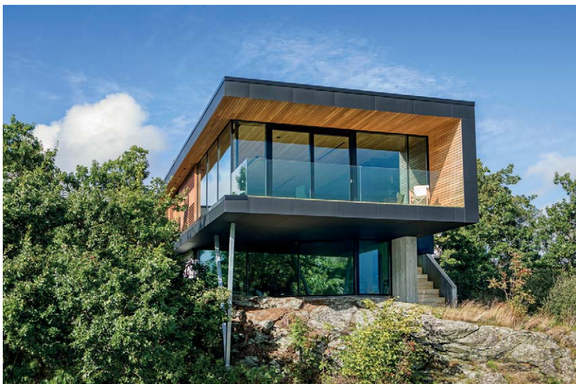
Der Betonsockel mit dem integrierten Erdgeschoss erscheint eng mit dem felsigen Untergrund verbunden. Der 91 m 3 große Familienraum im Obergeschoss ist von einer grandiosen Panorama-Aussicht geprägt, die eine über Eck laufende, raumhohe Glasfassade ermöglicht (Fassadensystem Schüco FWS 50.HI kombiniert mit dem Hebeschiebesystem Schüco ASS 70.HI). (© Sindre Ellingsen, Sandnes, NO)
