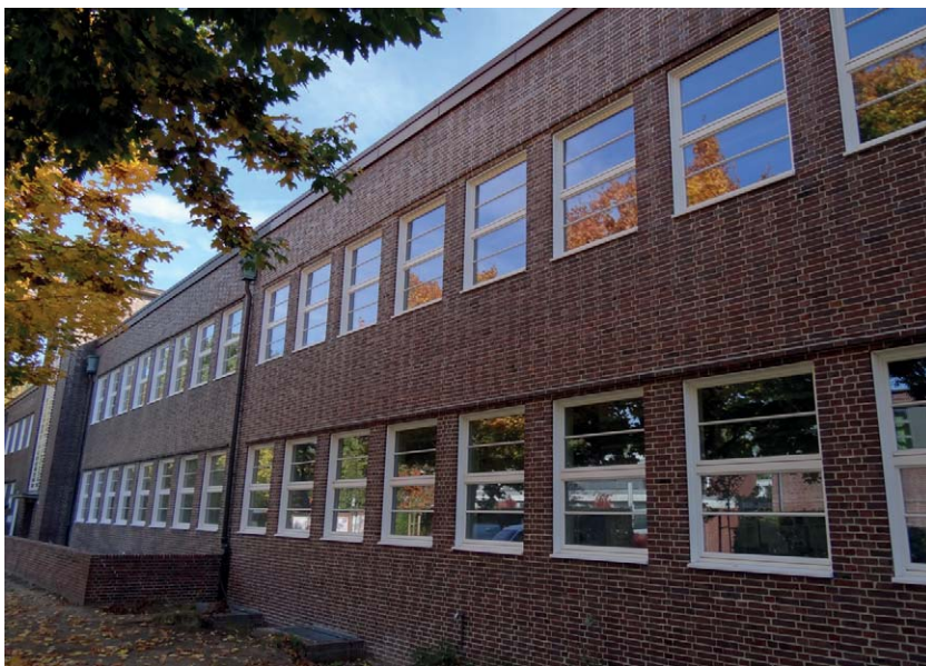
Ein aktuelles Sanierungsbeispiel zeigt das Walddorfer Gymnasium in Hamburg. Das aus dem Jahr 1929 stammende Gebäude erhielt 167 neue Vertikal-Schiebefenster, die den Originalen fast bis aufs Haar gleichen. (© Jörg Pfäffinger)
