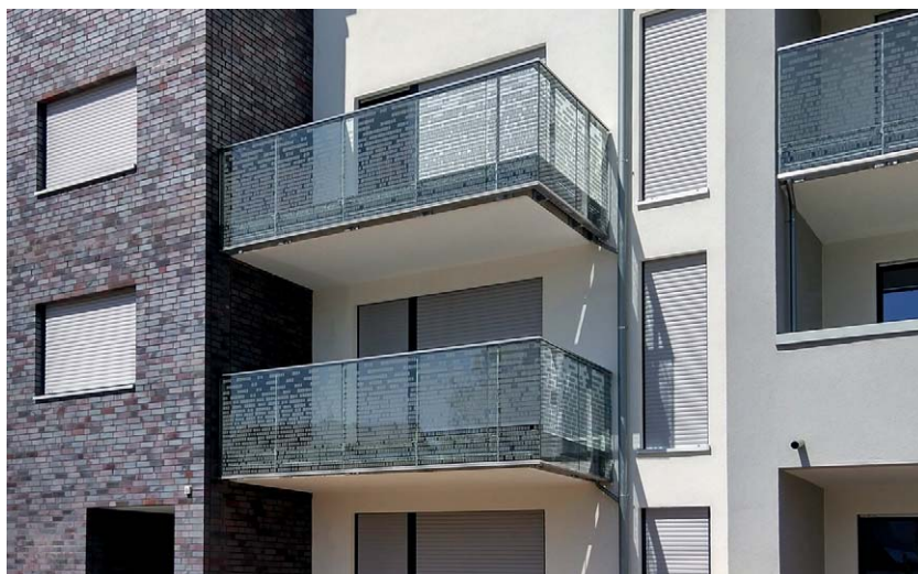
Mit Strichcodes gestaltete Balkonverglasungen sind Blickschutz und Ornament zugleich und vermitteln Informationen (Foto: Martin Pässler/Saint-Gobain GLASSOLUTIONS).
