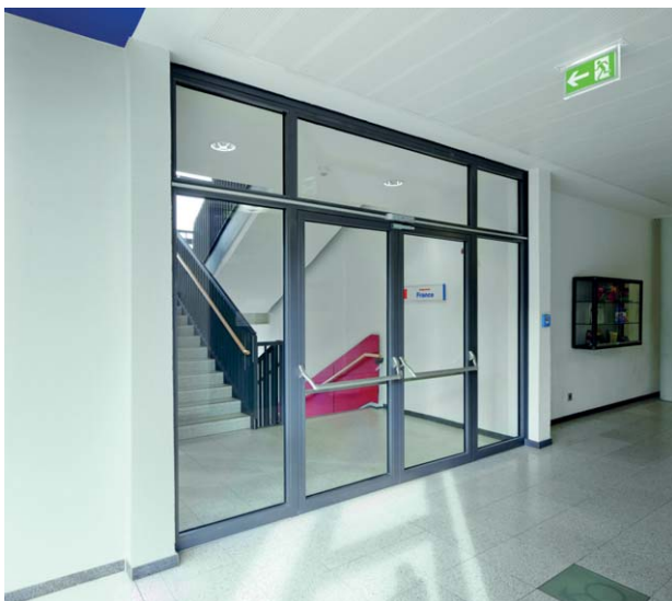
Wirksamen Schutz für Fluchttüren wie Anti-Panik-Türen bieten Verbund-sicherheitsgläser (Bildnachweis: Schüco International GmbH).
