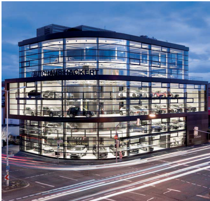
Für die Außenverglasung des Heilbronner Autohauses Hackert kam Guardian SunGuard® SNX 50 zum Einsatz. (© pierer.net)
