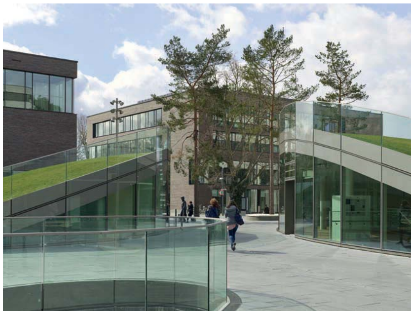
Die komplexen Verglasungen wurden mit Schollglas-Produkten gefertigt. Um ein homogenes Fassadenbild zu erreichen, wurde der Randverbund umlaufend mit einer speziellen Metallic-Keramikfarbe abgedeckt. (Foto: Roland Halbe)
