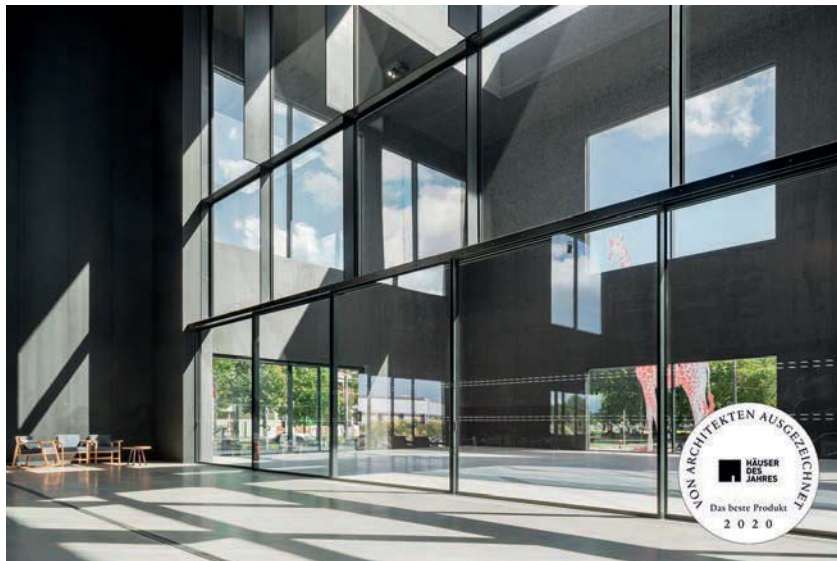
Theatre de Maillon in Straßburg: Mehrflügelige cero Schiebeanlagen in einer Breite von 12 sowie 18 Metern und 3,60 Meter Höhe lassen sich mühelos manuell öffnen. Im Boden eingelassene Schienen verbinden die Räume schwellenlos. (© Solarlux GmbH)
