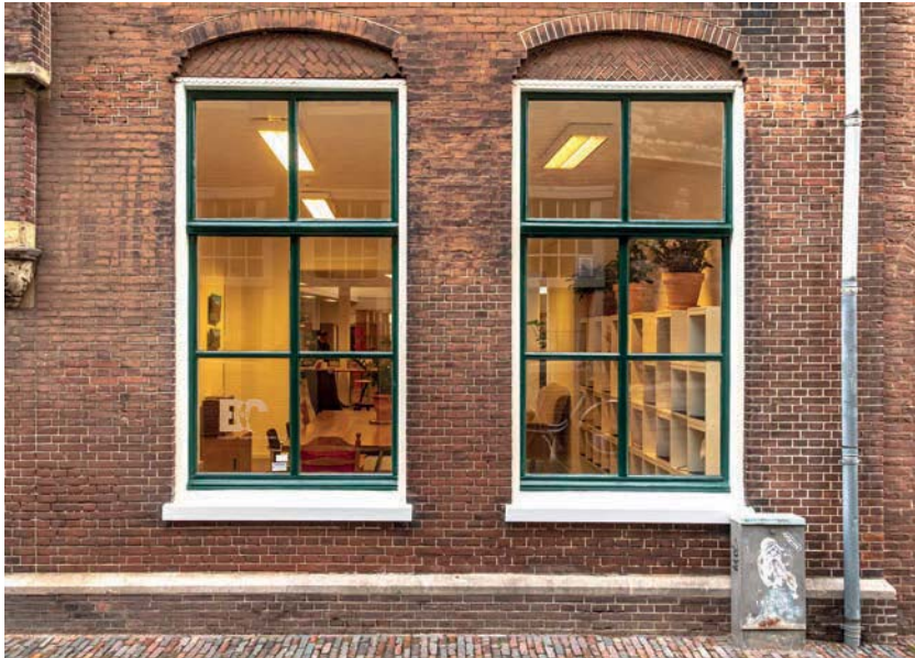
Fineo, installiert in den historischen Fenstern einer Bibliothek im niederländischen Leyden. (Foto: AGC Glass Europe)
