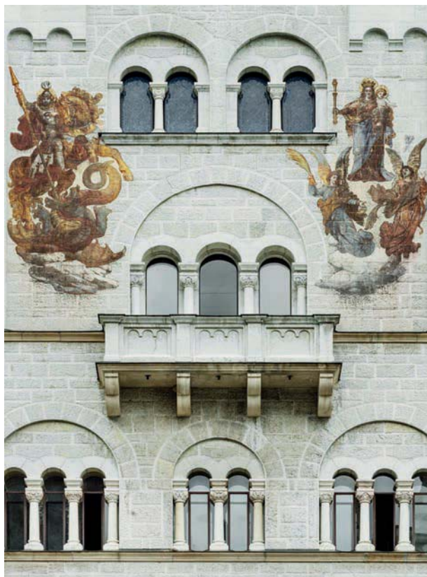
Die entspiegelte Schutzverglasung SCHOTT AMIRAN® Heritage Protect schützt die vier Fenster des Sängersaals vor Witterungen und sorgt für guten Durchblick. (Foto: SCHOTT)
