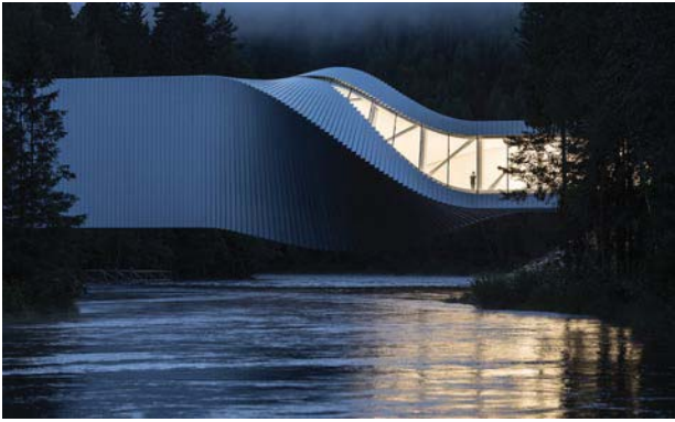
Mit einer 90-Grad-Drehung macht „The Twist“ im norwegischen Jevnaker bei Oslo von sich reden. Die Gläser lieferte Saint-Gobain Glassolutions. Die Glasfassade wurde als „Structural Glazing“ Fassade realisiert. (Foto: Laurian Ghinitoiu)
