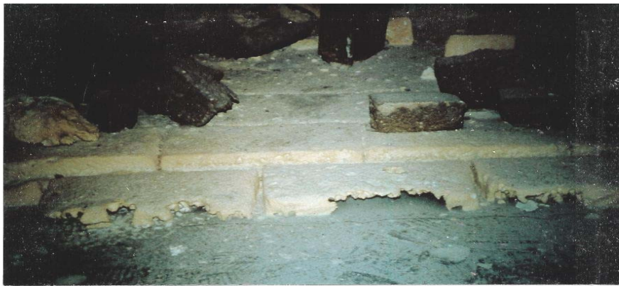
Bild 4: Korrosion durch Aufwärtsbohren.
