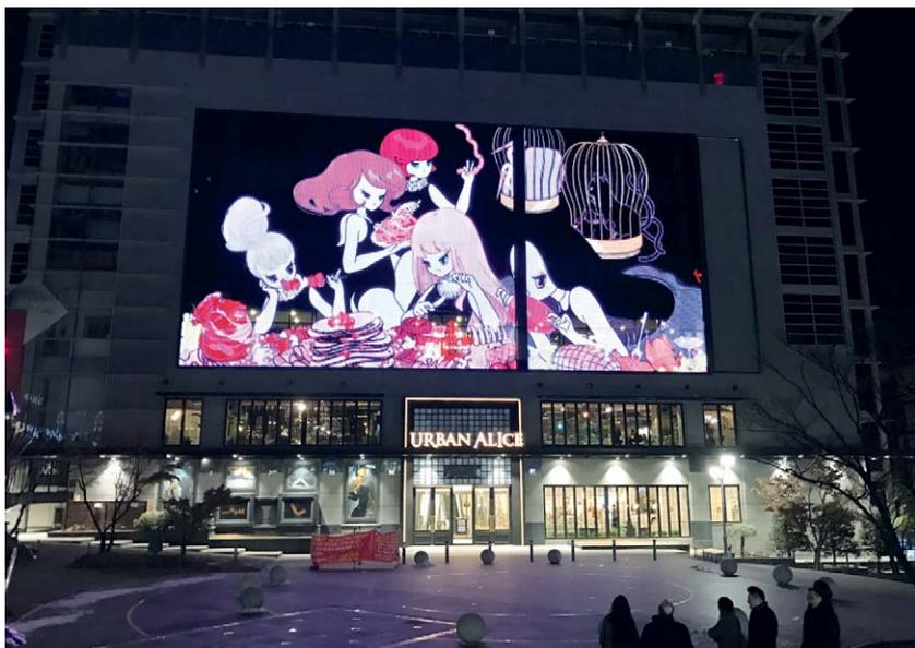
Das von Kömmerling und G-SMATT entwickelte G-Smatt Glass ist Display und konstruktives Bauelement zugleich und lässt sich wie hier in Seoul, Südkorea, direkt in die Fassade integrieren (Bildnachweis: Kömmerling Chemische Fabrik).
