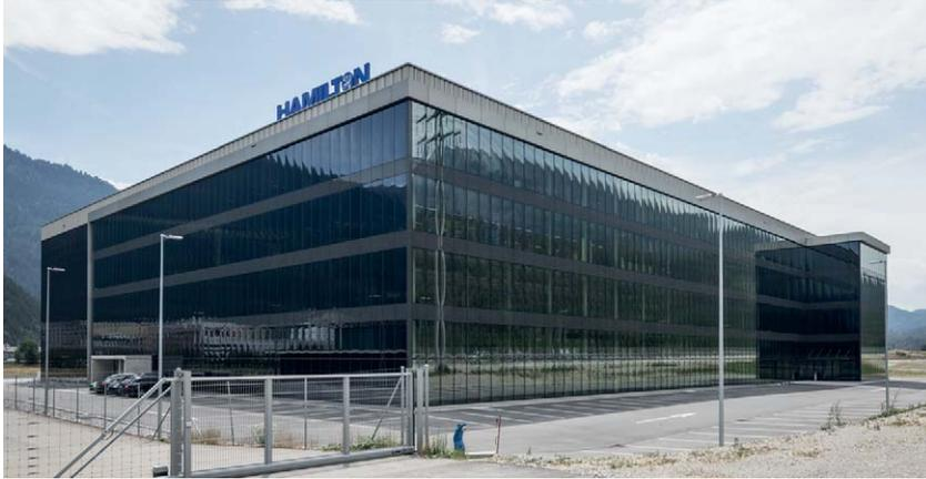
Die Fassade des neuen Produktions- und Verwaltungsgebäudes besteht aus Photovoltaikflächen und Ganzglaselementen, die mit dem elektrochromen SageGlass ausgestattet sind. (@SageGlass, Fotograf Ingo Rasp)
