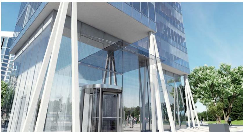
*Vision Stripe verleiht Fassaden eine künstlerische Note und erzeugt Energie, erhält aber gleichzeitig weitgehend die Lichtdurchlässigkeit und Funktionalität der Verglasung. (Foto: AGC Interpane)*
